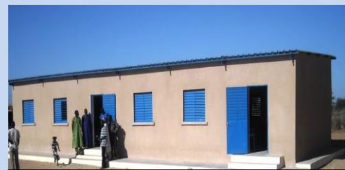
Blocs de salle de classe réalisée avec l'appui du Pndl à Nguene Sarr
